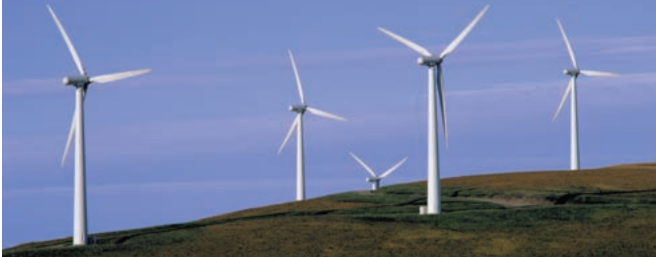
風力発電設備
